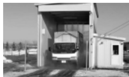
写真② 冬期間(-20度)でも使用できる車両消毒装置。通過時に上下、左右から消毒液シャワーを浴びる。
