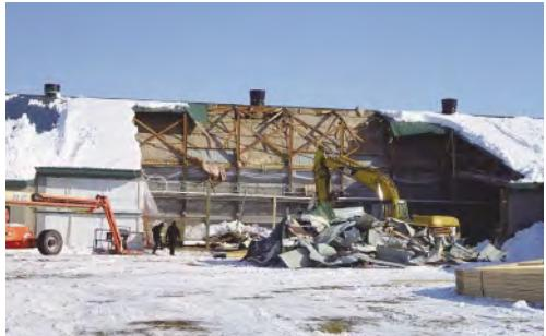
大雪により屋根が崩落した牛舎
