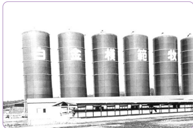
写真3. 公共牧場に建設された気密サイロ
