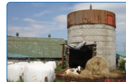
(写真2) 壁に穴を開け、子牛小屋として活用しているブロックサイロ
