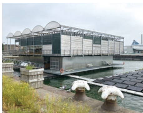
Floating Farmの外観。
